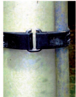
Collier de câble en caoutchouc avec agrafe inox
