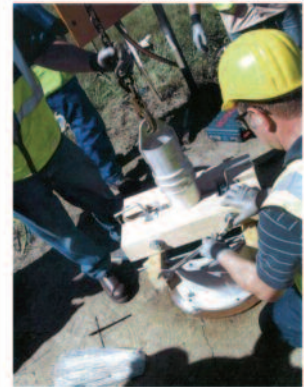
Collier de retenue en bois, à serrage rapide
