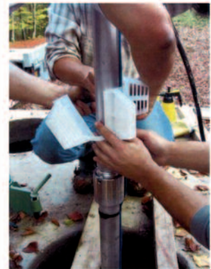
Centreur à lamelles en PEHD incolore. Deux tailles : type 70 ou type 140
