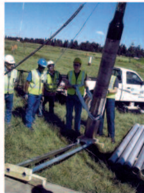
Chariot de manutention pour la mise en place des pompes et des tuyaux
